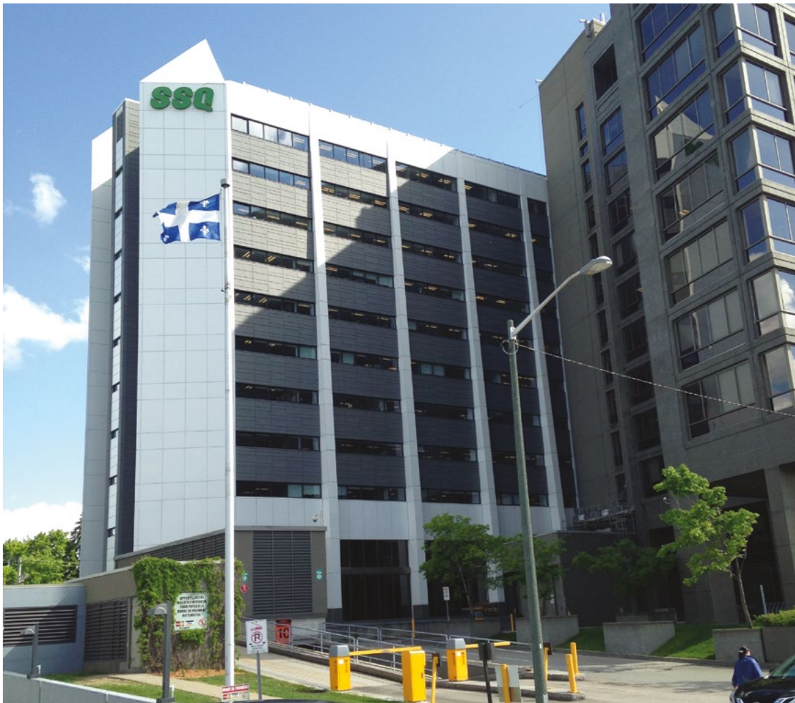
L'Édifce SSQ Tour du Saint-Laurent à Québec
